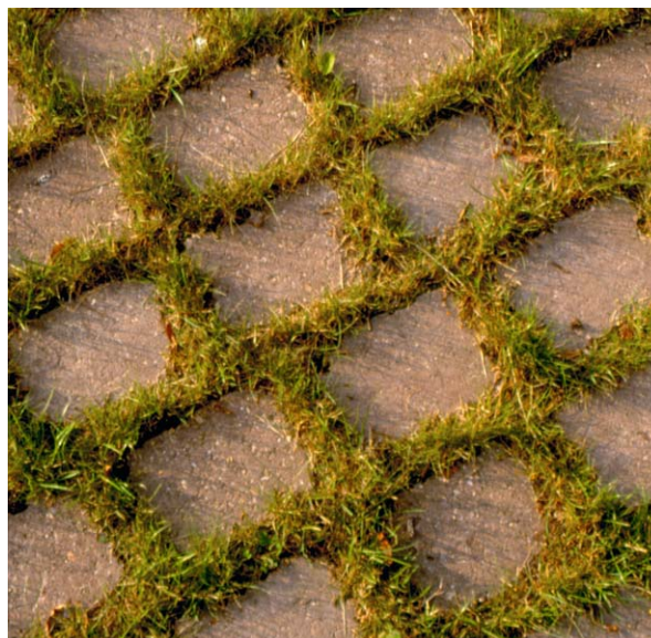
Pflastersteine lassen sich mit 2 cm Abstand zu Rasenpflaster verlegen. Regenwasser kann so versickern, niedrigwüchsige Wildkräuter finden eine ökologische Nische.
